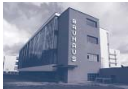
「バウハウス・デッサウ校舎外観」
