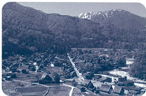
写真提供 岐阜県白川村役場
